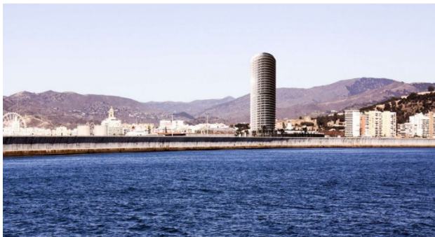
Proyecto Torre del Puerto, Málaga
